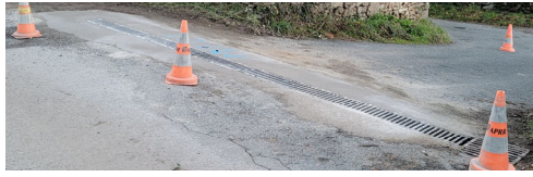
Remise en état du caniveau
